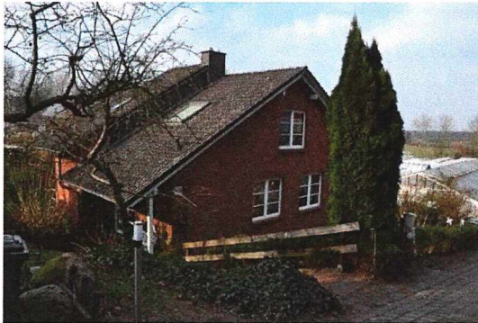
Streitberg 14b mit Gartenbaubetrieb
